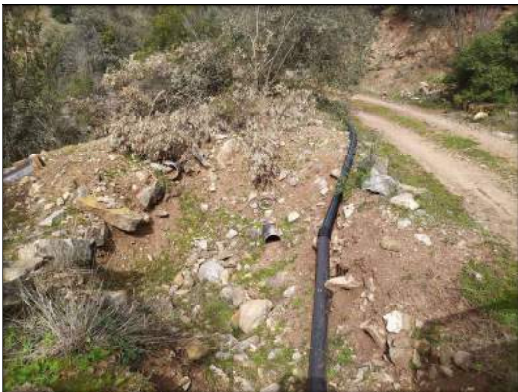
Φωτογραφία 6: Τμήμα δικτύου του Δυτικού τομέα όπου έχει τοπικά αντικατασταθεί με πλαστικές σωλήνες, η τοποθέτηση έγινε επιφανειακά.
