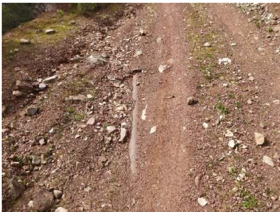
Φωτογραφία 8: Δίκτυο Δυτικού τομέα, διακρίνεται μεταλλική σωλήνα σε τμήμα αγροτικής οδού όπου διέρχονται αγροτικά μηχανήματα.
