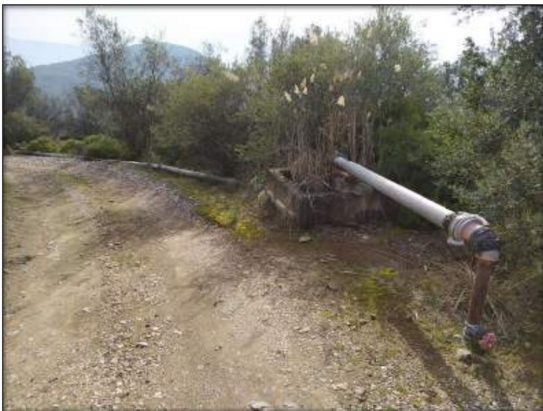
Φωτογραφία 5: Υφιστάμενο δίκτυο Ανατολικού τομέα, στη θέση αυτή λόγω της συνδεσμολογίας εντοπίζονται μεγάλες απώλειες νερού.
