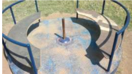
Φωτ. 1-4 : Επικίνδυνες και κατεστραμμένες κατασκευές, Έλλειψη δαπέδων ασφαλείας
